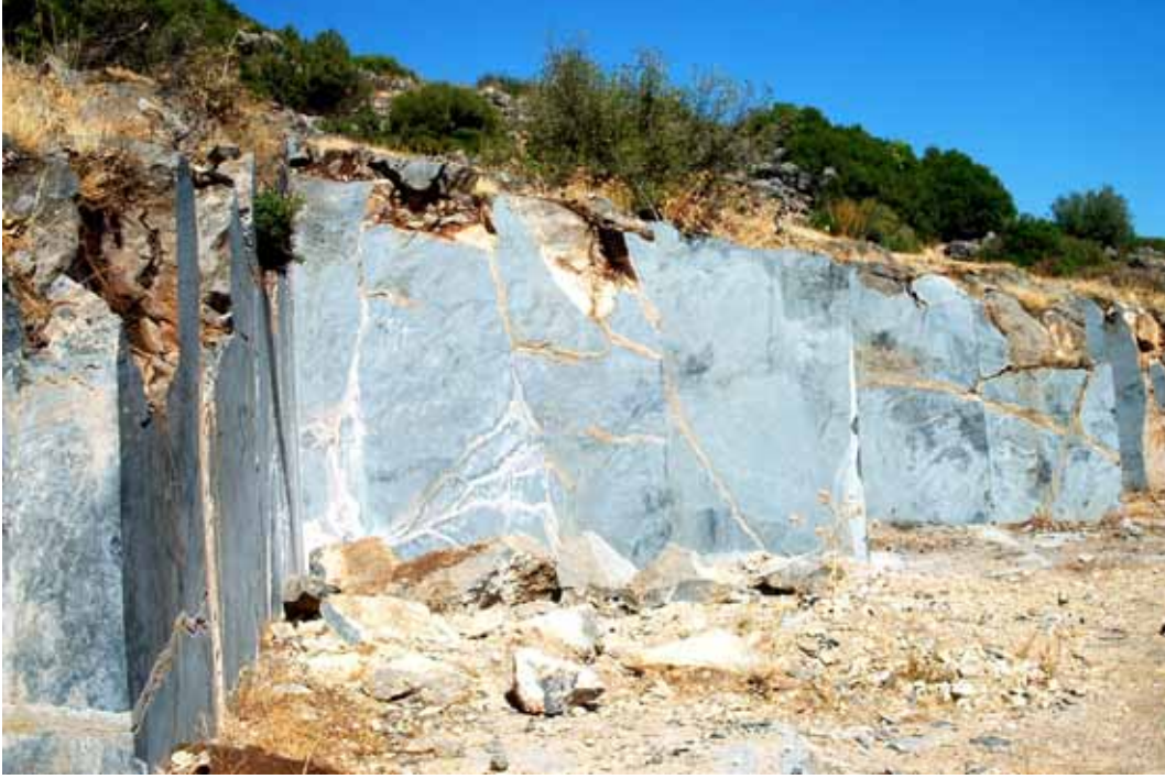
Şekil 2. Sahada kaya kütlelerinin konumu ve çatlaklarda dolgu malzemesinin durumu (K-G)
